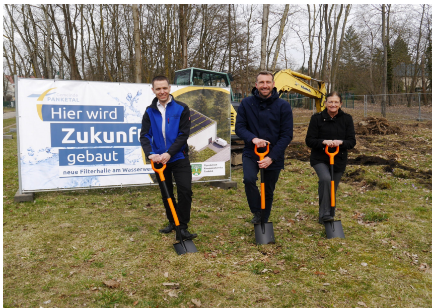
Erster Spatenstich für den Erweiterungsbau des Zepernicker Wasserwerks: Technischer Leiter Robert Glasmacher (l.), Bürgermeister Maximilian Wonke und Werkleiterin Heidrun Rinne.
