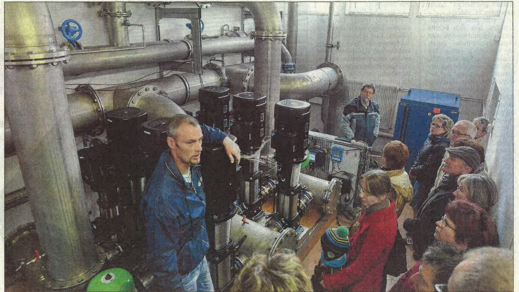
Bei der Führung durch das Wasserwerk: Haiko Schöne erklärt den etwa 20 Besuchern im Pumpenhaus, wie das Wasserwerk arbeitet. Die Pumpleistung beträgt im Jahr zwischen 750 000 und 1,2 Millionen Kubikmeter. Fotos (3): MOZ/Sergej Scheibe
